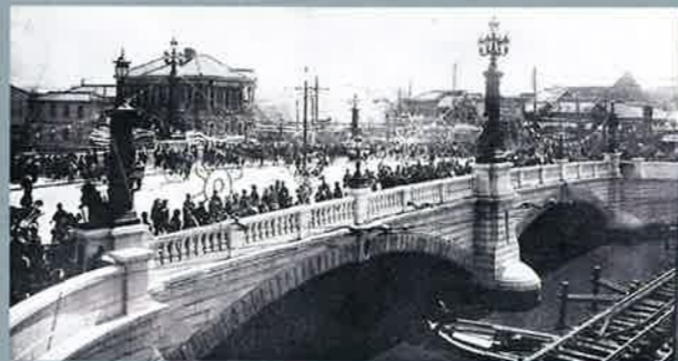
▲竣工した日本橋 / 1911年4月15日号
