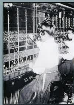
▲日本に2箇所しかない新式電話交換機 / 1909年8月1日号
