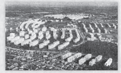
日本住宅公団常盤平団地
